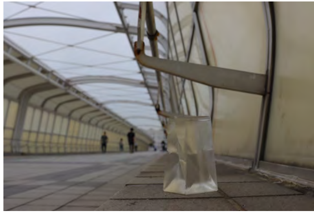
行為の気配（朝霧歩道橋）
